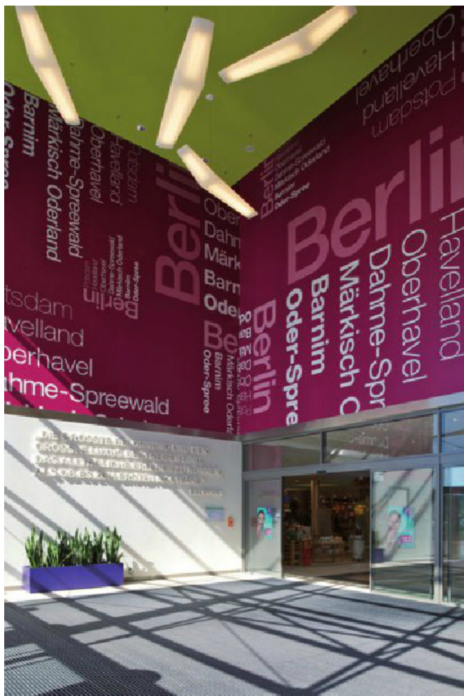
In den drei neuen Eingangsbereichen des A10-Einkaufszentrums wurden die Windfänge mit selbst gestaltetem und bedrucktem Digitalvlies verklebt. (Bilder: ECE)
